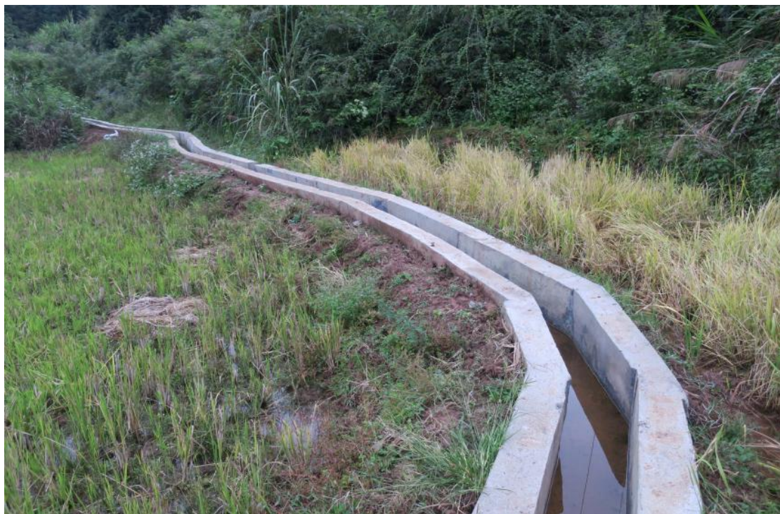
基础设施项目现场照片，灌溉渠工程
