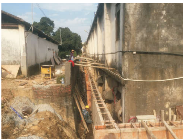
东莞信托运用财政帮扶资金协助大朗镇佛子凹村建设村道挡土墙
